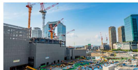
高層ビル工事の途中階や トラックの荷台・仮設事務所など
