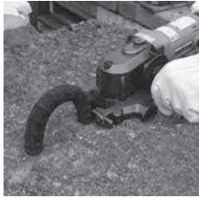
不要な鉄筋のソラ切断
