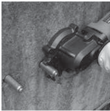
アンカーボルトの除去
