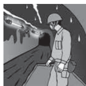
トンネルの仮設照明
