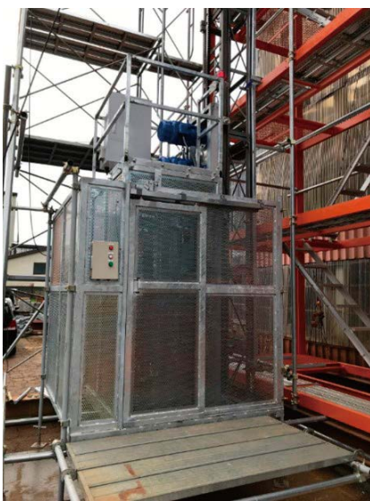
■ 立杭工事に下部作業台を取り付ける事が出来ます。
