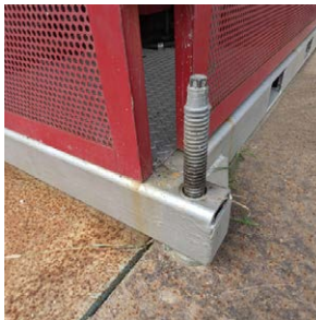
■ 下部ゲージ、昇降フレーム一括吊り ■ レベル出しジャッキ
