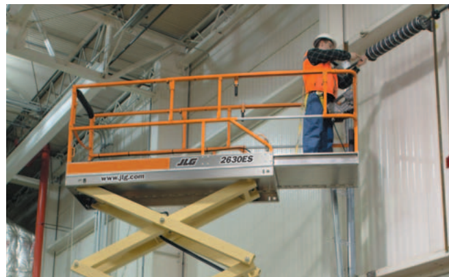
延長デッキで障害物越え作業
