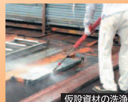
仮設資材の洗浄
