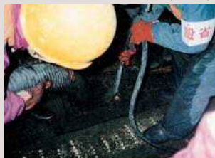
道路側溝清掃
