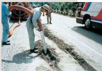
アスファルト切削くずの回収
