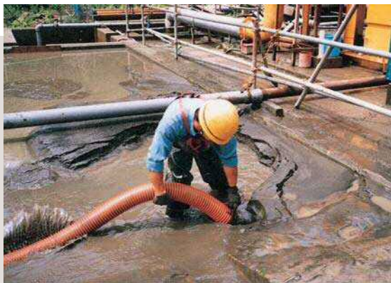
ピットの汚泥回収
