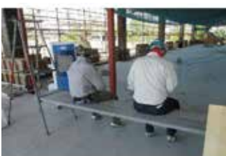
建築現場で使用
